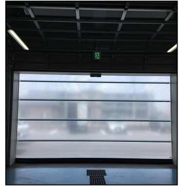
【工場内側から閉めた状態】
