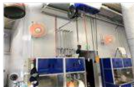
大型扇風機設置(習志野店) →
